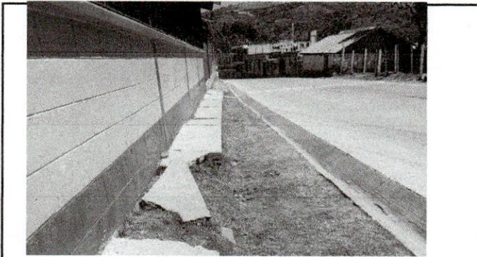
Foto 5: Reparación de concreto de banqueta.
